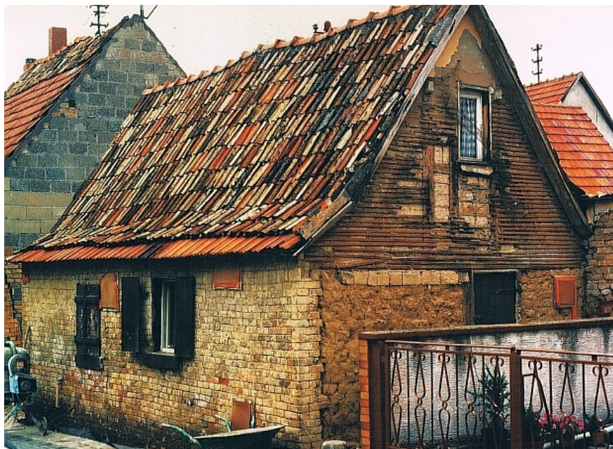
... und nach dem Entfernen des Putzes.
