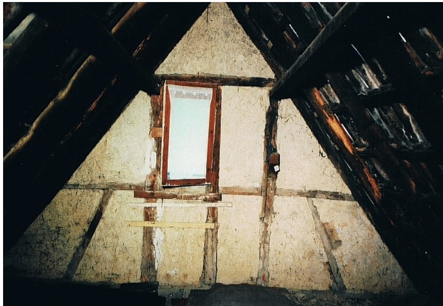
Fachwerkgiebel mit typischer Lehmausfachung
