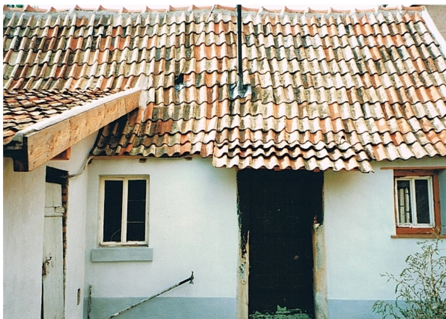
... und im neu verputzten Zustand.
