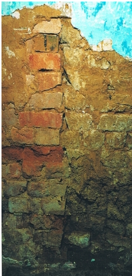
Links Backsteine, rechts oben Lehmsteine, rechts unten Bruchsteine
